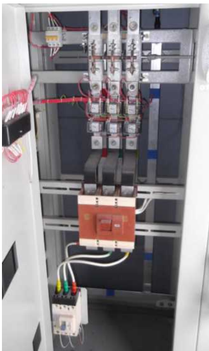
Рисунок 3 - вводная панель РУ-0,4 кВ
