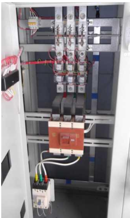
Рисунок 3 - вводная панель РУ-0,4 кВ
