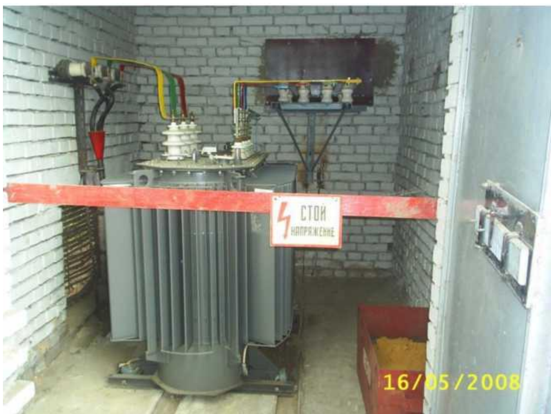
Рисунок 11 - Трансформатор марки ТМГ на ТП МУП «ВГЭС».
