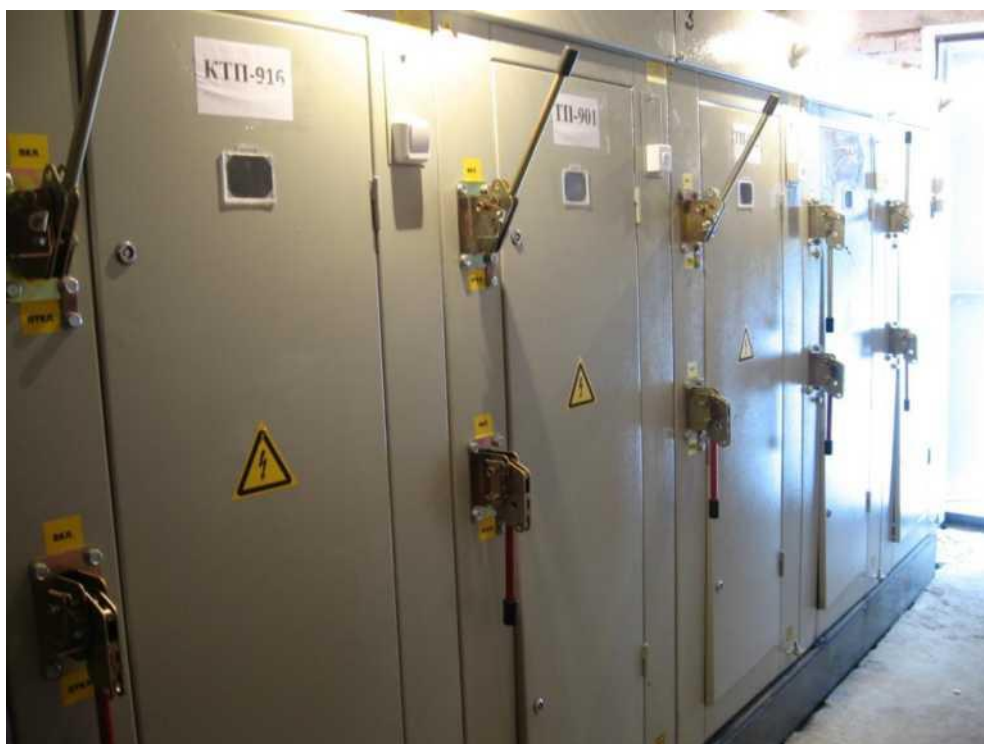
Рисунок 6 - общий вид РУ-6(10) кВ в ТП.
