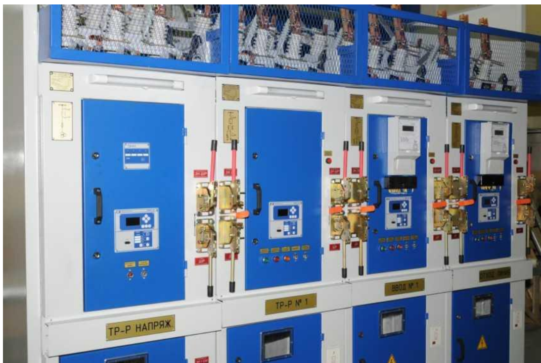
Рисунок 7 - Общий вид РУ-6(10) кВ в РП(РТП).
