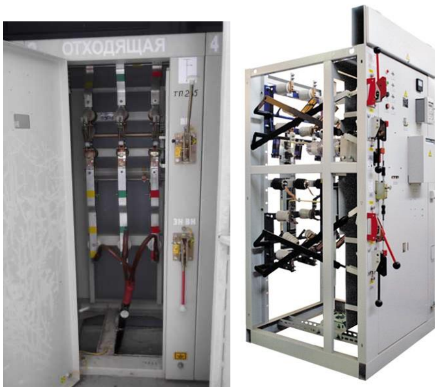
Рисунок 9 - линейная панель.
