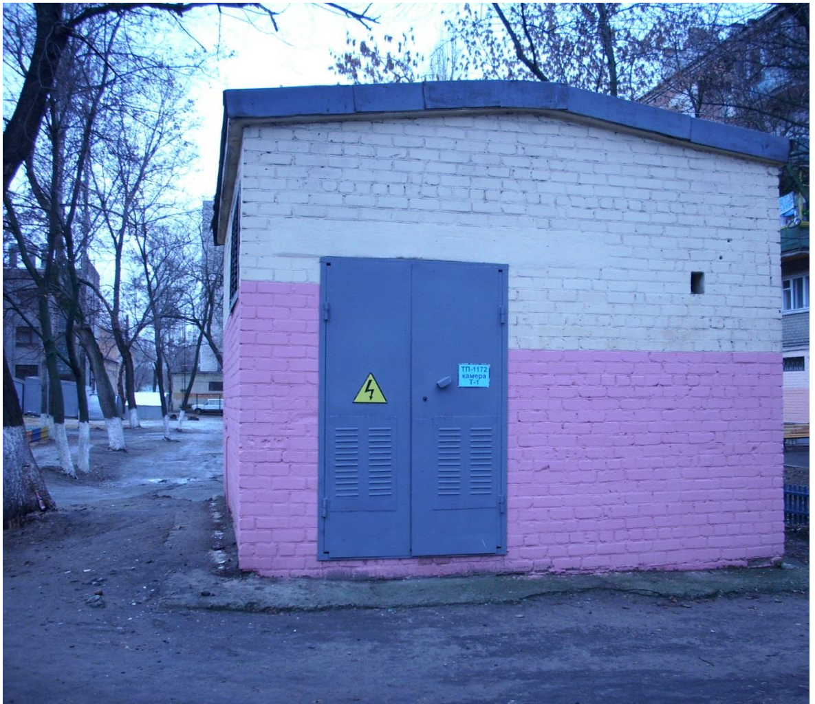
Рисунок 1 - ТП-1172 в кирпичном исполнении.
