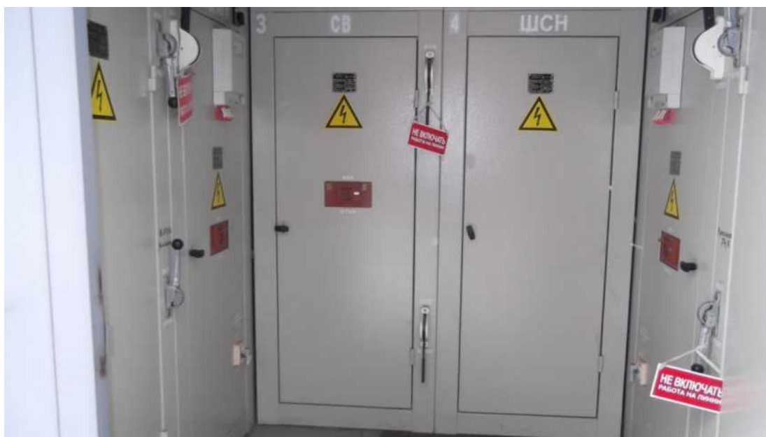
Рисунок 5 - Общий вид РУ-0,4 кВ ТП, КТП.
